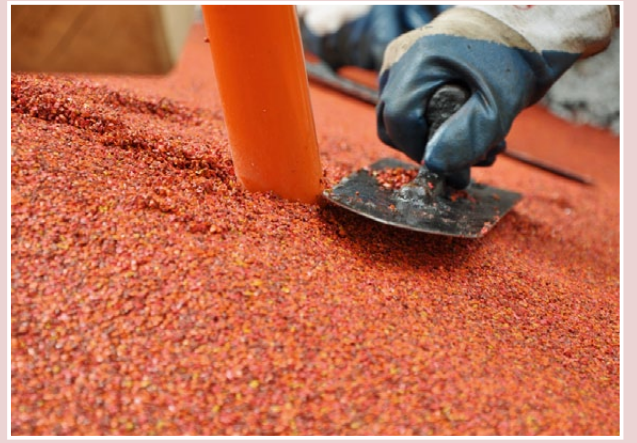
Abbildung 11: Verlegung des fugenlosen Fallschutzbelages in Handarbeit.
