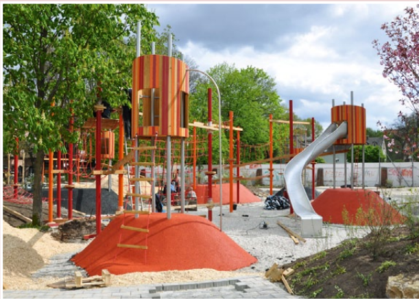
Abbildung 7: Ausführungsarbeiten im Sommer 2014.
