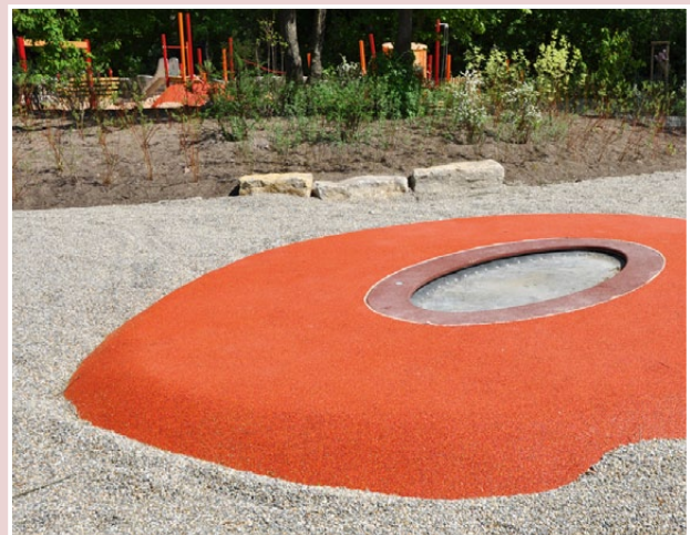
Abbildung 22: Symbiose von Gummibelag und Fallschutzkies.
