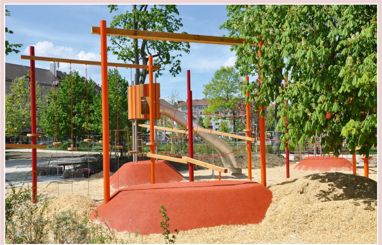
Abbildung 18: Niedrigseilanlage kurz vor Fertigstellung.
