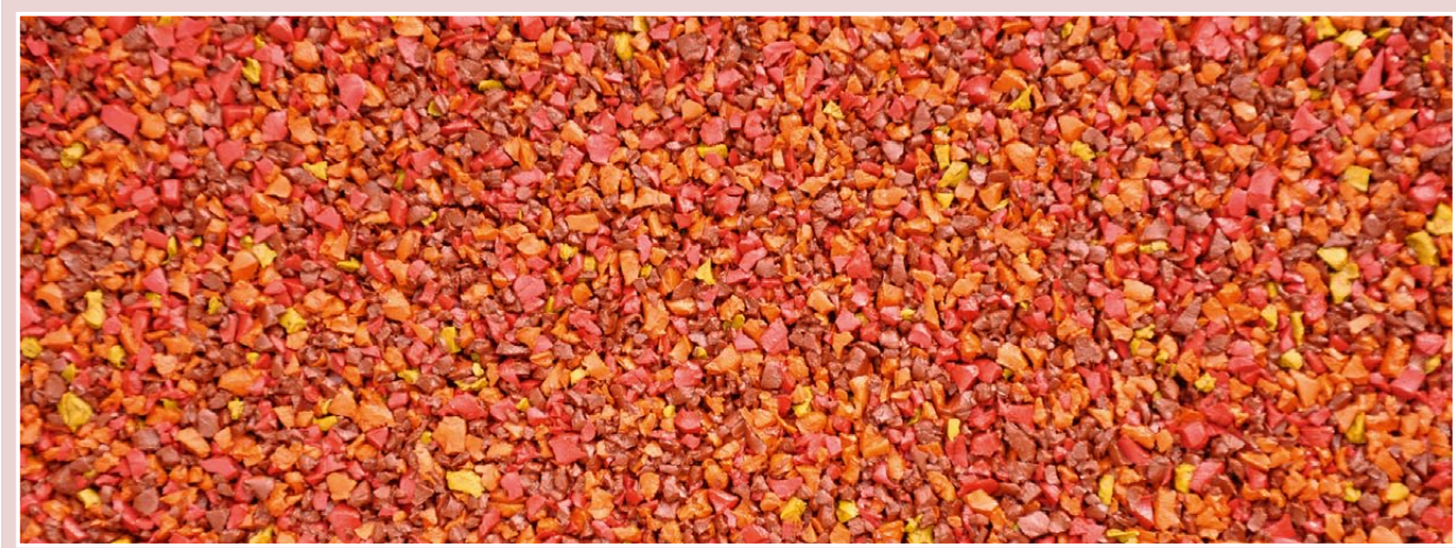
Abbildung 16: Detailaufnahme des Fallschutzbelages. Hier lässt sich der Granulatmix erkennen, der das leuchtende Gesamtbild bestimmt.
