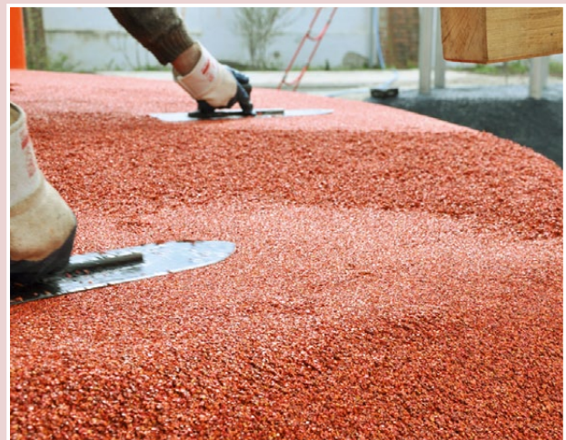
Abbildung 21: Handwerkliche Ausführung des Fallschutzbelags.
