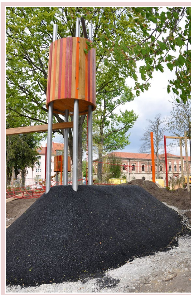
Abbildung 12: Den Grundkörper bildet schwarzes Gummi- granulat, welches auf einen vormodellierten Betonkörper aufgebracht wird.
