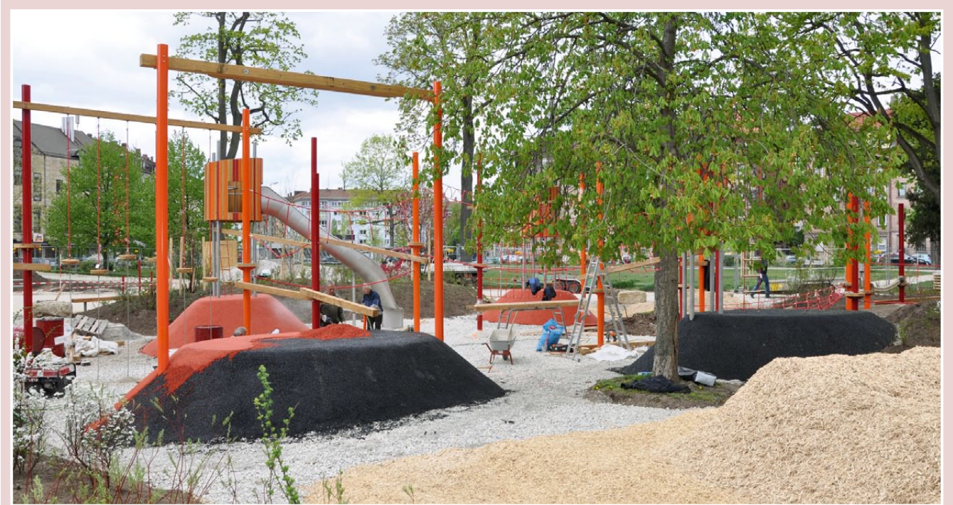
Abbildung 17: Niedrigseilanlage während der Bauphase.
